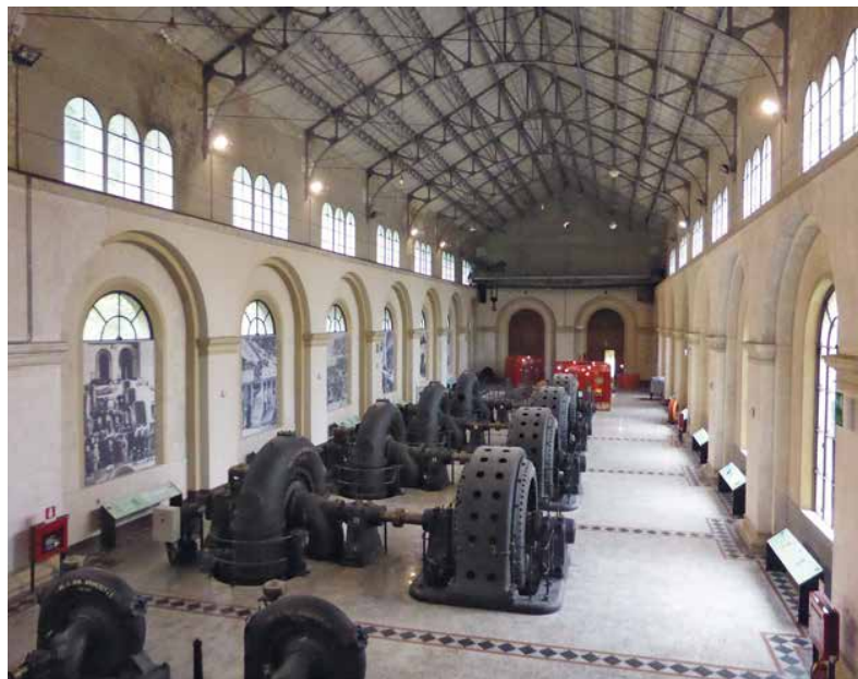
Centrale elettrica Antonio Pitter, Malnisio di Montereale Valcellina (Pordenone)
