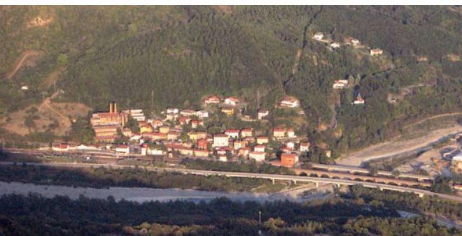
Vista panoramica di Ghiare di Berceto. A sinistra, la Fornace
