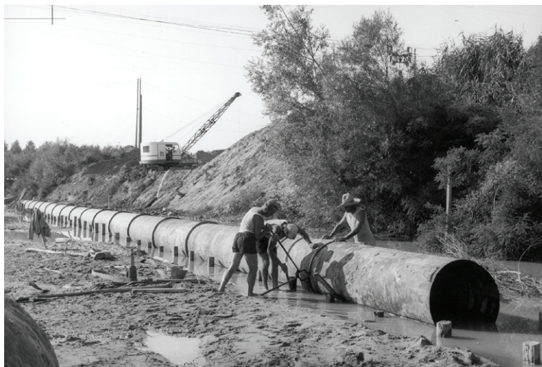
Lavorazione della Botte sotto il Reno. Posi dei tubi per la portata di magra del Reno, s.d. Archivio CER, foto Enrico Pasquali
