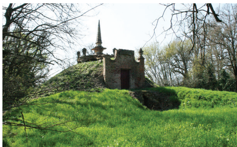
Ghiacciaia semi interrata inserita nel giardino all'inglese di Villa Malvezzi a Bagnara di Budrio (Bologna)
