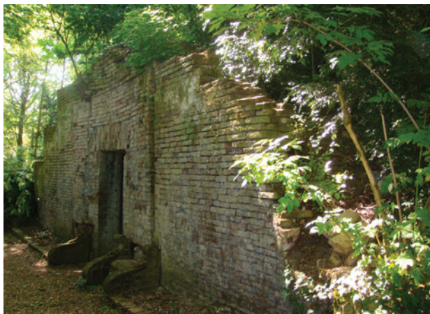
Facciata del vestibolo della ghiacciaia di Villa Nicolaj a Calcarà di Crespellano (Valsamoggia, Bologna)
