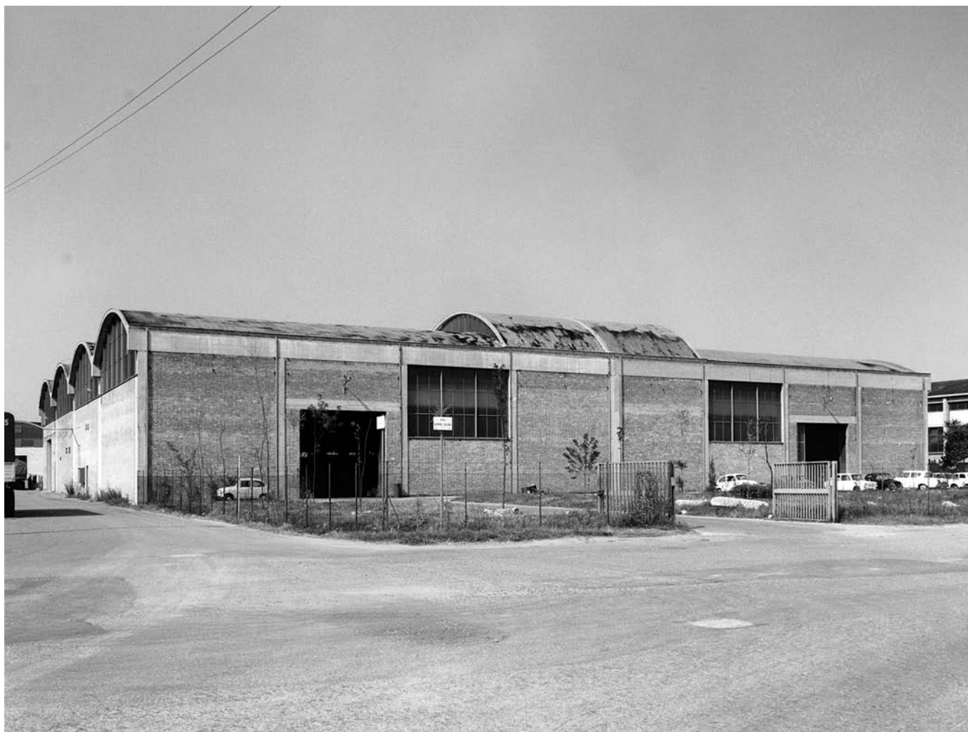
Capannoni in Via Calzoni utilizzati per la produzione durante la costruzione del nuovo stabilimento, in seguito per il montaggio macchine Museo del Patrimonio Industriale, fondo Minganti
