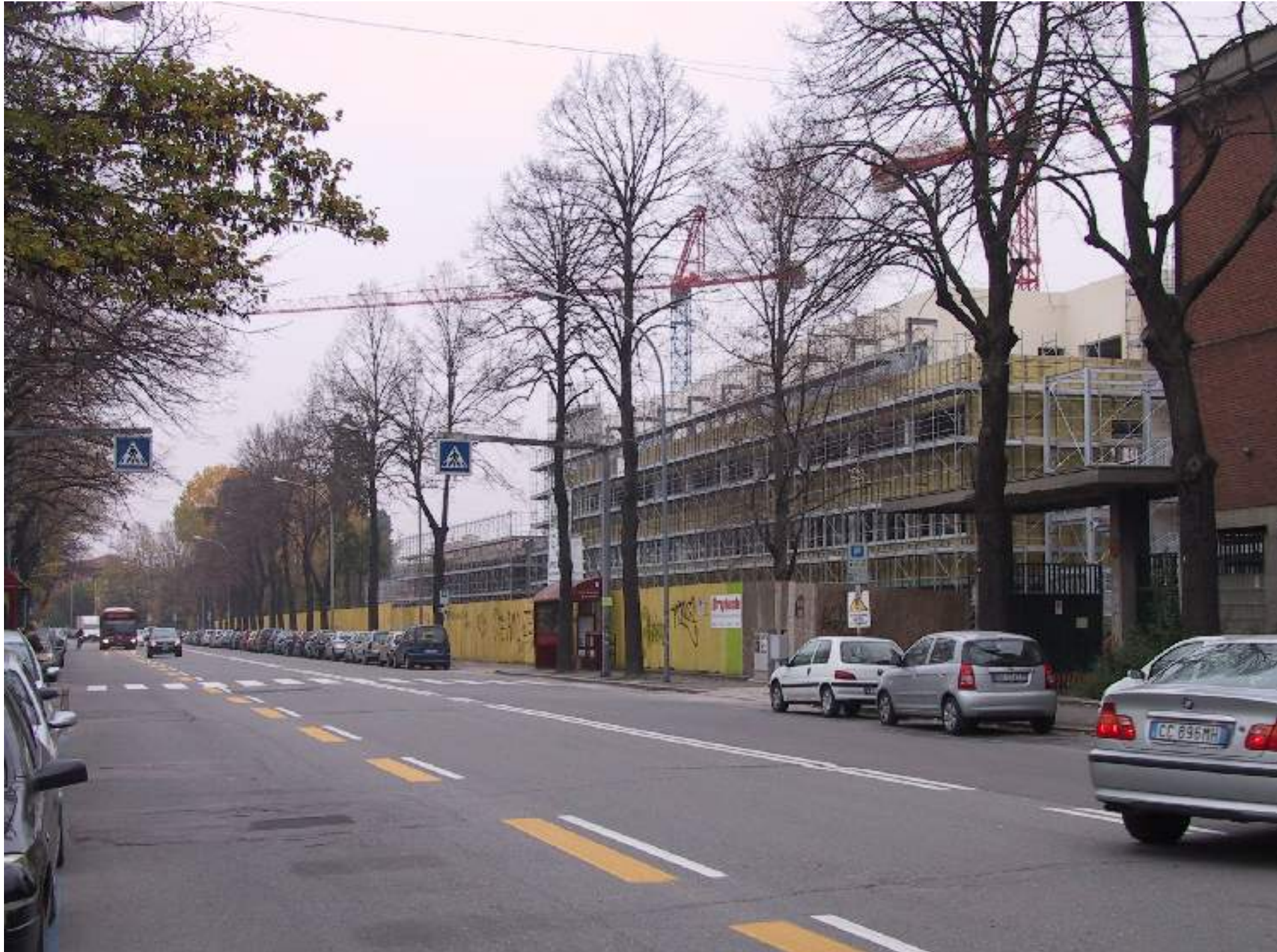
FASE 1 - NOVEMBRE 2009 REALIZZAZIONE LUNGO VIA DI CORTICELLA
