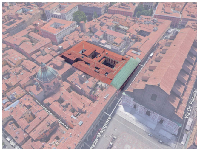
1: Foto Area Edificio / Flight foto building
